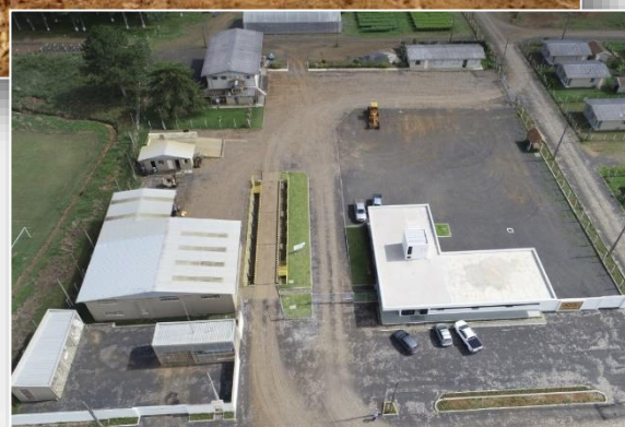
Figura 35. Vista aérea da estrutura existente na sede da empresa. (Fonte: Acervo AFA)
